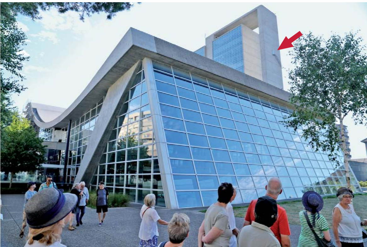
Kongresshaus mit Aussentreppe (Pfeil)
