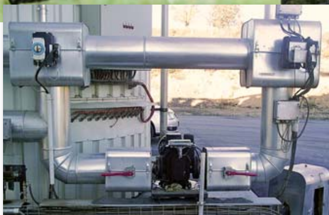
Elektrisch beheizte Pumpe einer Bitumenanlage zur Förderung von flüssigem Heiss-Bitumen
